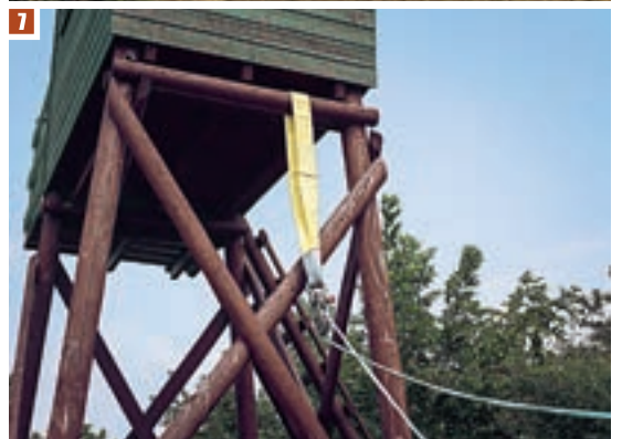
3 Verbaute Seilwinden sind 1. Wahl, das Seil soll dabei waagrecht aus der Winde herauslaufen. Eine Kabelfernbedienung hat einen kleinen Aktionsradius, eine kabellose Fernbedienung (Funk) ist für die Wildbringung ideal (Bild 3 und 4).
