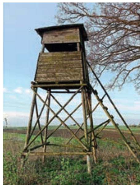
Der Kanzelbock besteht aus den Hauptstützen (hier: konisch verlaufend), den gekreuzten Verstrebungen (Windverband) sowie den unteren und oberen horizontalen Querriegeln.
